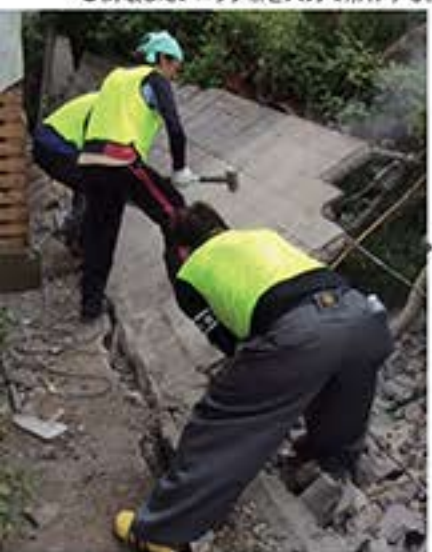
●倒壊したブロック塀を人力で解体する。
